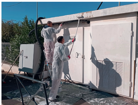
Chantier transfos Enedis - Mpt
