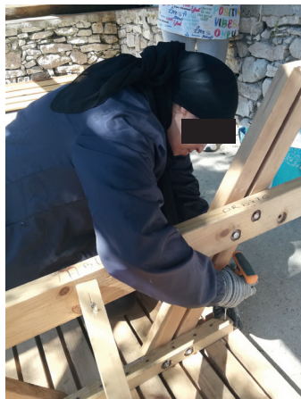
Chantier Espace Gisèle Halimi - Mpt Mosson
